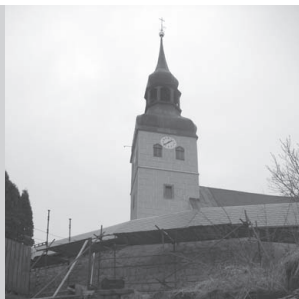
Probíhající oprava ambitu u kostela Sv. Jiří v Chříbské
