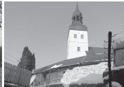
Zabezpečení ambitu u kostela Sv. Jiří ve Chřibské
