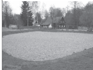
Kořenová čistírna odpadních vod v Srbské Kamenici
