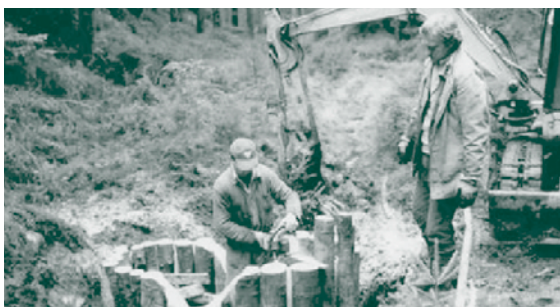
Práce na revitalizaci Pryskyřičného dolu
